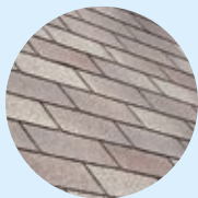
Ancien bardeau d'asphalte (armé de feutre) : 15 à 25 ans
