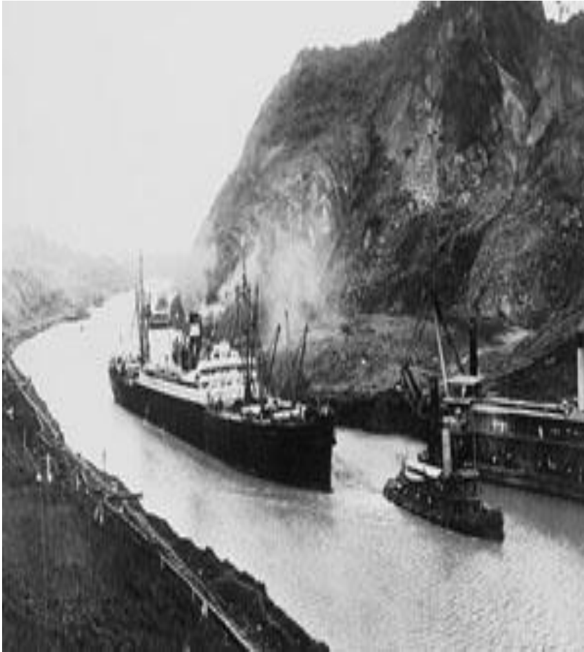
1881 Inicio construcción Canal de Panamá
