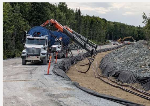
Sur la photo : installation du réseau collecteur enfoui dans l'emprise des chemins
